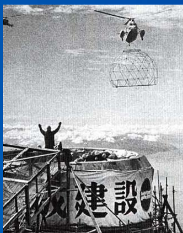
1964年、ベテラン操縦士も死を覚悟した乱気流の中、山頂に到達したレーダー用ドーム。 (写真提供：三菱電機)
